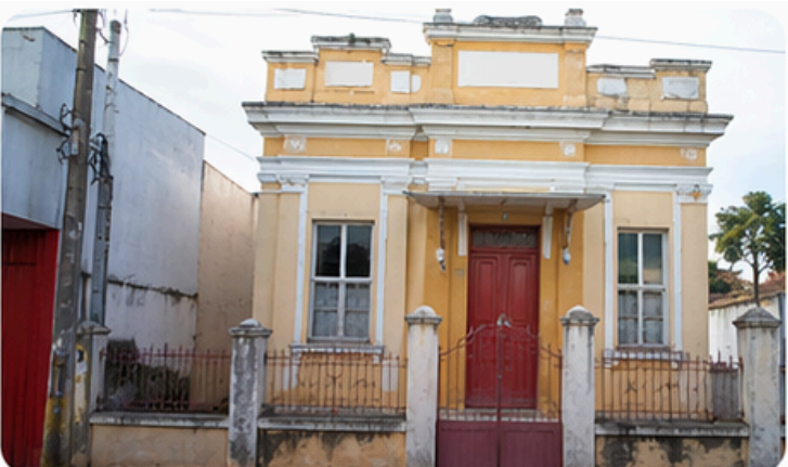
Fachadas tombadas da Rua José Bonifácio
