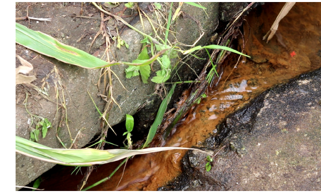
água da fonte escorrendo para bueiro
