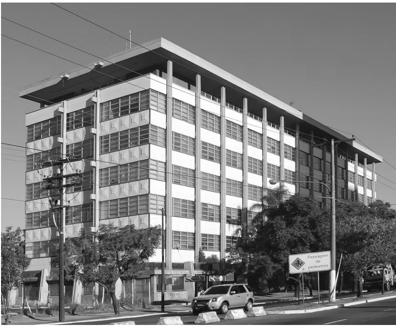
EDIFÍCIO DA SMOV ATUALMENTE Autor: Sérgio M. Marques. Fonte: MooMMA, 2024.
